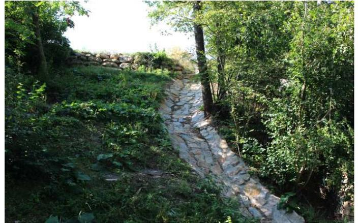
Für das Oberflächenentwässerungsprojekt am Buchberg konnte der Bau des Rückhaltebeckens mit Abflussgerinne fertiggestellt werden. Die anfallenden Oberflächenwässer werden im Rückhaltebecken Buchberg gesammelt und in das Rückhaltebecken in der Apothekergasse abgeleitet.
